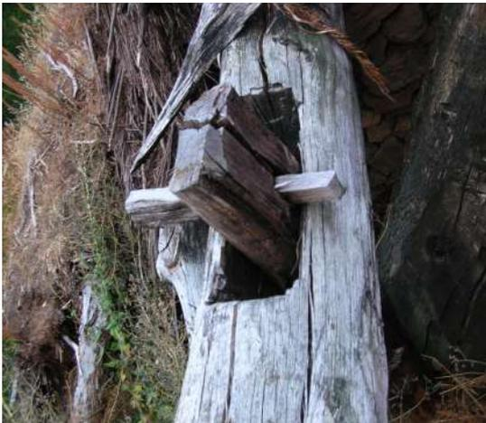
Figura 175. Clavos de madera entre los restos de una vivienda circular en Ibias.
