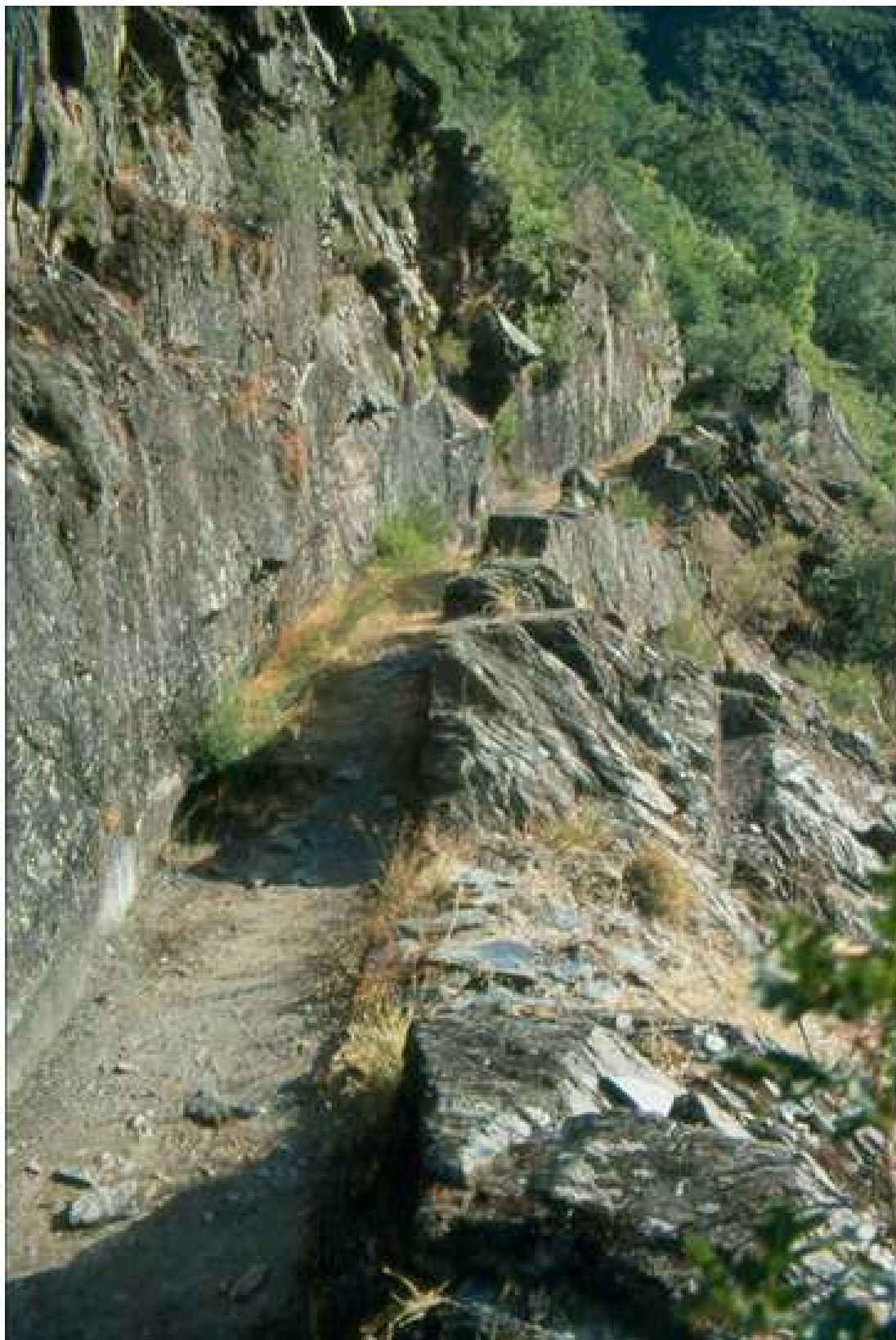
Corte en la roca del canal C-1 de Las Médulas (Llamas de Cabrera)
