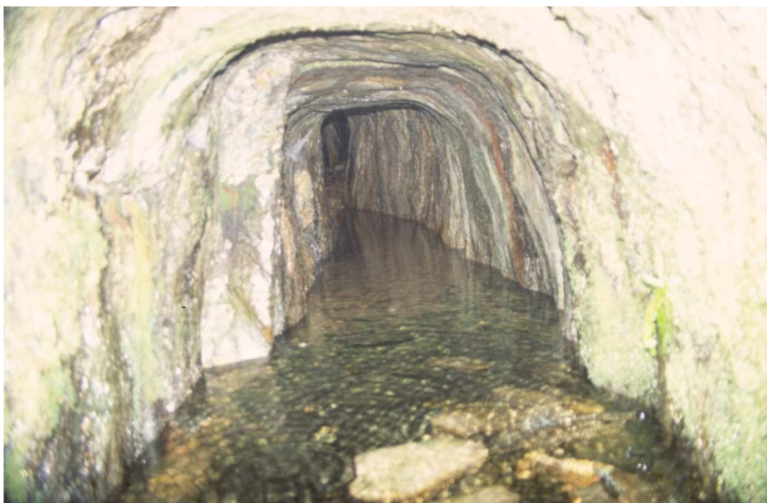
Galería principal de drenaje de la mina de oro romana de Llamas de Cabrera
